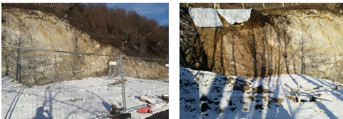
Abb. 5: Aushub Baugrube des Bauvorhabens Bergweg 6, Ortseinsicht vom 18.12.2018
