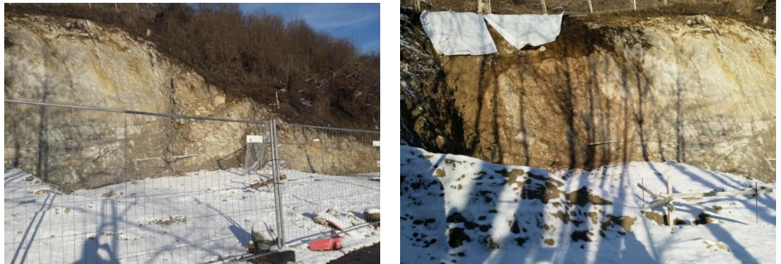
Abb. 3: Aushub Baugrube des Bauvorhabens Bergweg 6, Ortseinsicht vom 18.12.2018
