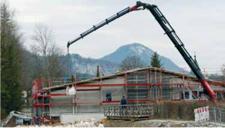
Der provisorische Absperrdamm am Kiefern-Mühlbachkanal wird mit Hilfe eines Krans zurückgebaut © Hoffmann
