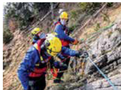
Arbeiten am Seilgänger
