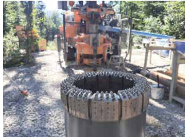
Mit solchen Bohrkronen arbeitet sich die Bohrmannschaft in das Gebirge vor. Rund 200 Meter unter dem Gelände sollen künftig Eisenbahntunnel verlaufen.
