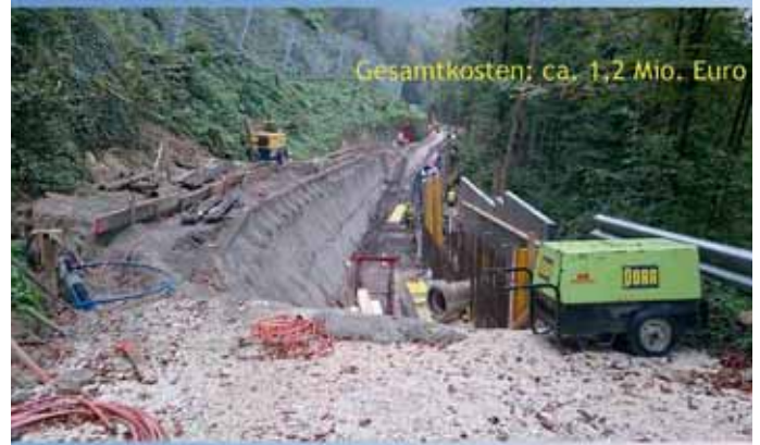
Sanierung Mühlauer Straße und Errichtung von Lawinen- u. Steinschlagschutzeinrichtung
