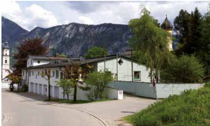
Generalsanierung KiGa St. Martin (236.000 €, Förderung 75.000 €)
