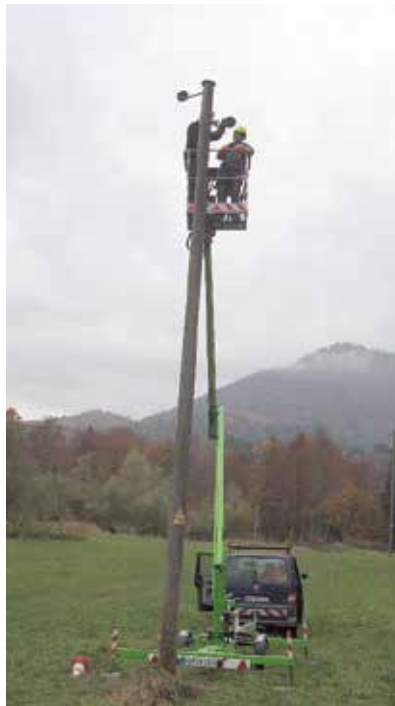
Abbau von Freileitungen
