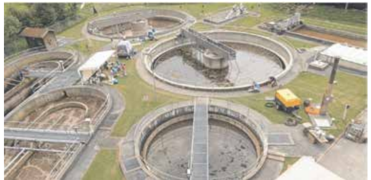
Gemeinschaftskläranlage Kiefersfelden - Thiersee Sanierung Becken: ca. 80.000 €
