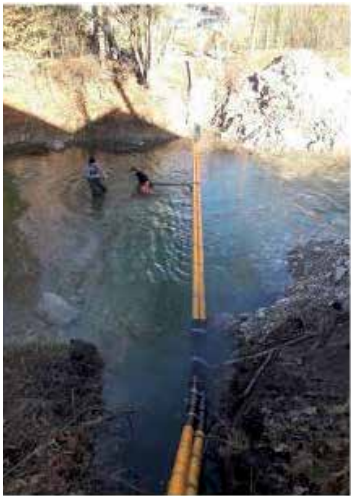
Verlegung der Stromversorgung durch den Kieferbach
