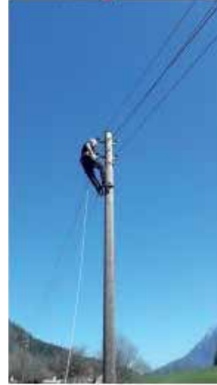
Abbau bzw. Instandhaltung der Strom-Freileitungen
