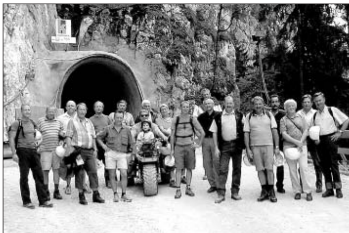
Nordportal: Einer Einladung des Ebbser Gemeinderates folgend besichtigte der Kieferer Gemeinderat mit Bürgermeister Erich Ellmerer den im Bau befindlichen Kaiseraltunnel und durchschritten ihn zu Fuß.
