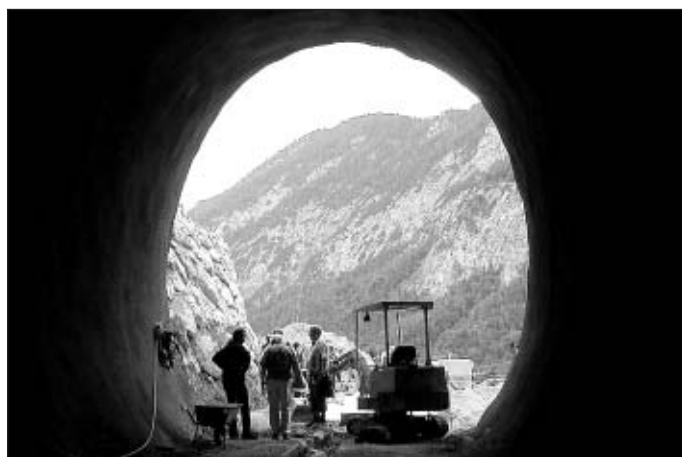
Südportal: Nach 813 Metern öffnet sich der Kaiseraltunnel oberhalb des Zottenhofes und trifft dort nach wenigen Metern auf die bestehende Talstraße.
