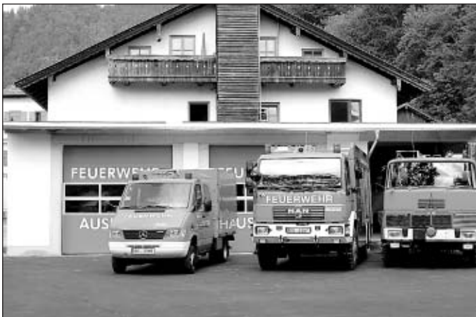
Die neue Fahrzeughalle bietet Platz für die zwei Einsatzfahrzeuge der Freiwilligen Feuerwehr Mühlbach und ermöglicht zeitgerechte Unterbringung aller Einsatzmittel.
