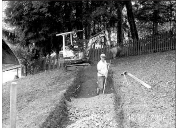
Bau des Rollstuhlweges
