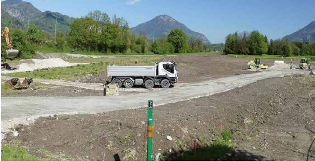
Im Gewerbegebiet Kaiserreich werden die ersten Zufahrten angelegt
