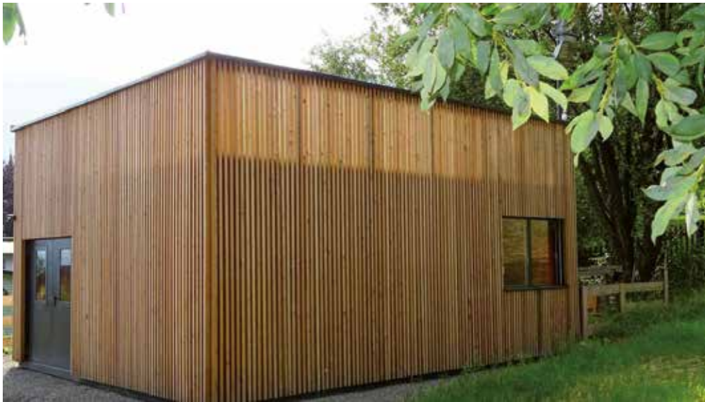
Ein mit Holz verkleideter Container: Er soll den Kindern des neuen Kieffersfeldener Waldkindergartens Unterschlupf bieten
