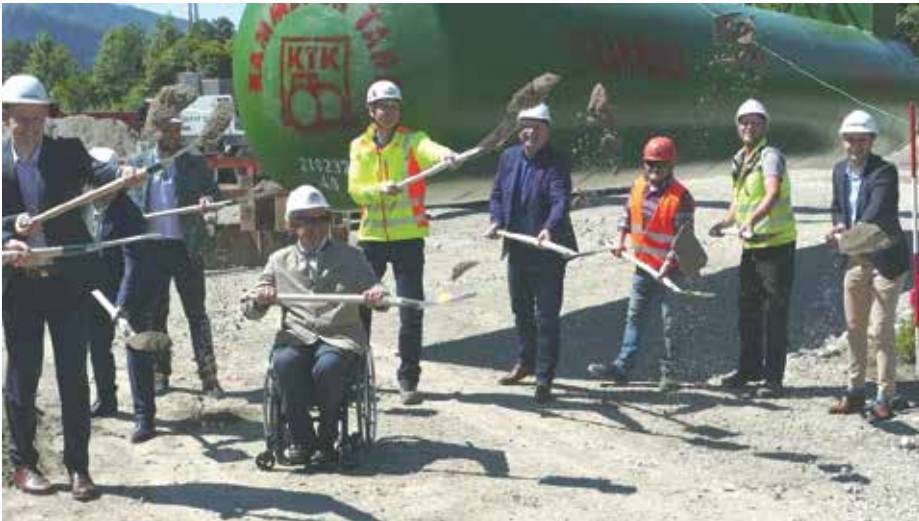
Beim Spatenstich der Tankstelle im Kaiserreich wurden viele Schaufeln geschwungen
