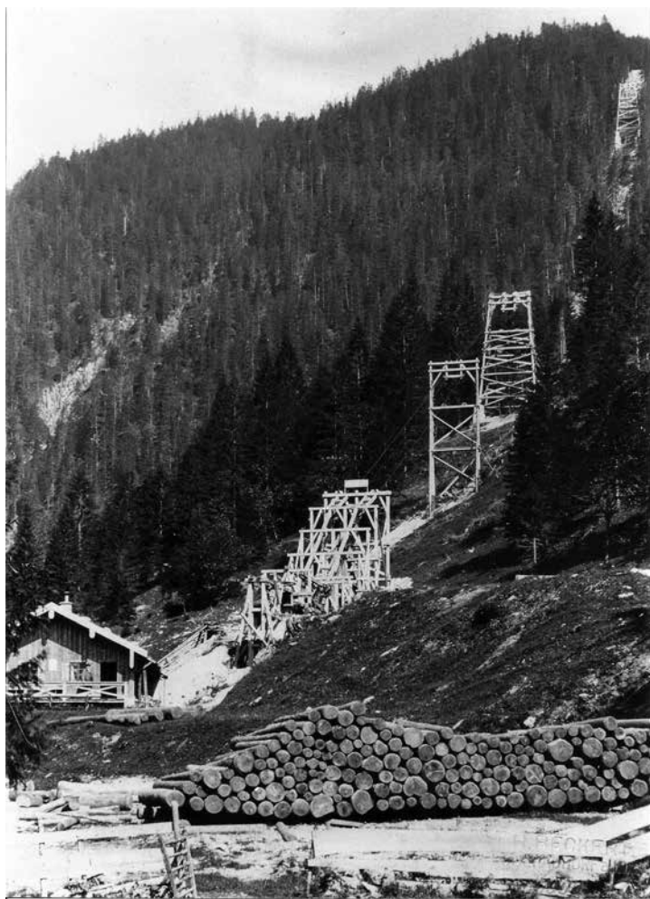
Die Talstation der forstamtlichen Drahtseilbahn im Gießenbachtal, aufgenommen um 1909.
