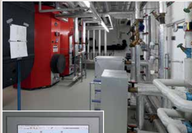
In der Hauptsache sind es die Plattenwärmetauscher die eine Versorgung „on demand“ ermöglichen.
