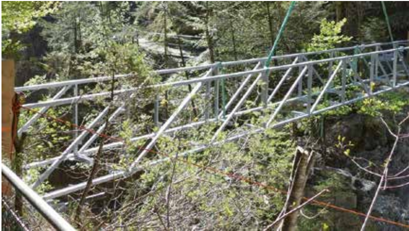
Millimeterarbeit war angesagt, als der Stahlträger vom Helikopter abgeseigt wurde
