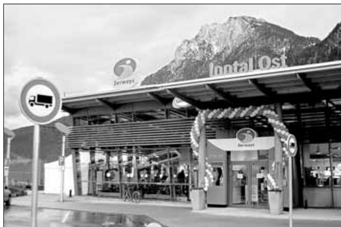
Mit einem modernen Konzept, das europäische Normen setzen soll, wartet die neu eröffnete Tank- und Rastanlage Inntal Ost auf. Zudem stehen 80 Pkw- und 75 Lkw-/Busparkplätze bereit.
