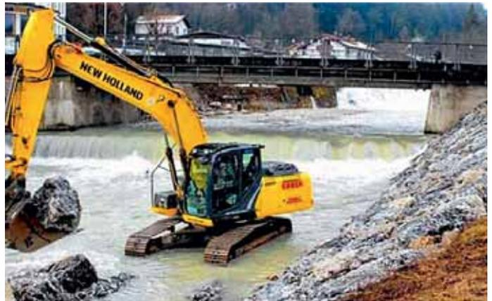
Mit schwerem Gerät wurde die Uferböschung des Kieferbachs saniert, nachdem wegen des Hochwassers Steine und Geröll aus der Uferbefestigung ausgeschwemmt worden waren.
