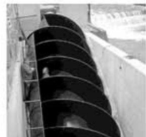
Montage der Wasserkraftschnecke am Bergwirthwehr
