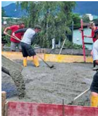
Errichtung des Betonfundaments mit Fa. Moserbau
