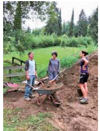
Auffüllung der Fundamente in Handarbeit
