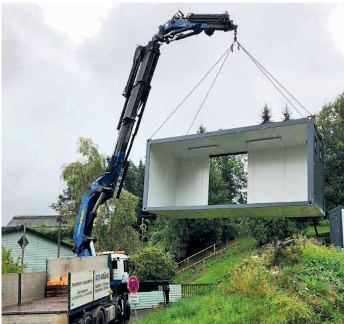
Anlieferung der Container-Eemente durch Fa. Recon
