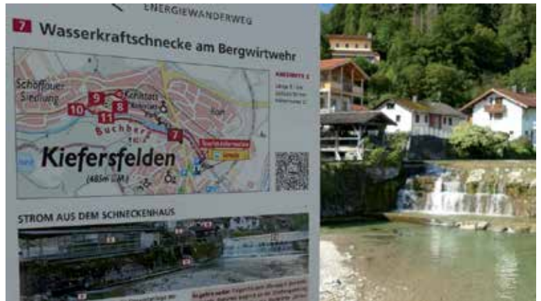
Infotafel an der Wasserkraftschnecke am Bergwirtwehr mitten in Kiefersfelden
