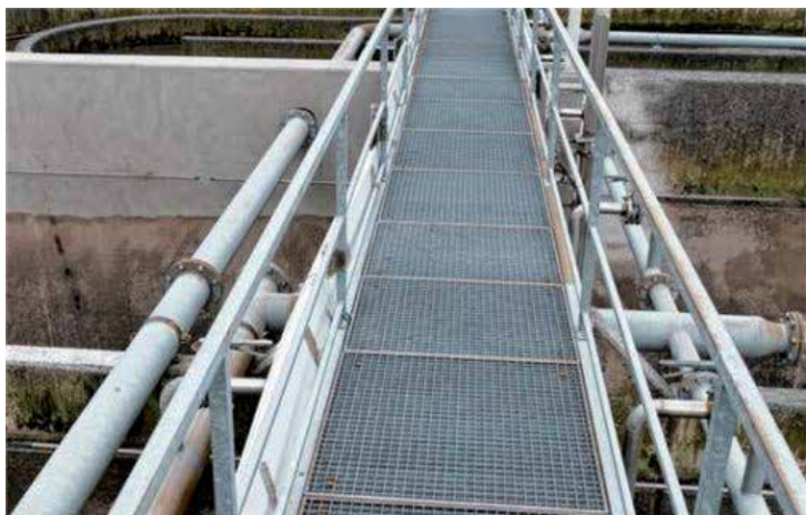
Der rechte Teil des Belebungsbeckens muss noch gereinigt werden. Poröse, brüchige Dichtungen werden erneuert
