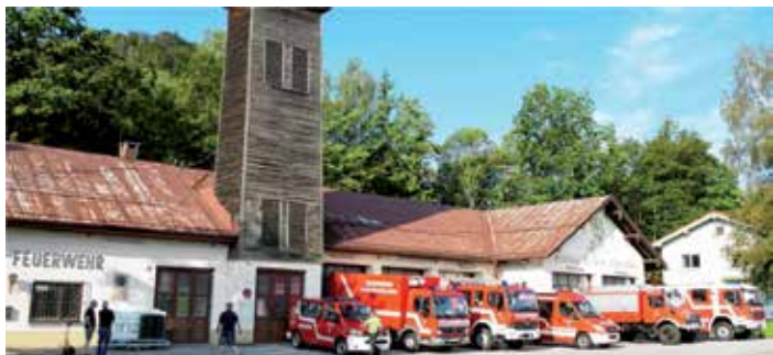
Das in die Jahre gekommene Feuerwehrhaus wird schon bald Geschichte sein. Foto hoffmann
