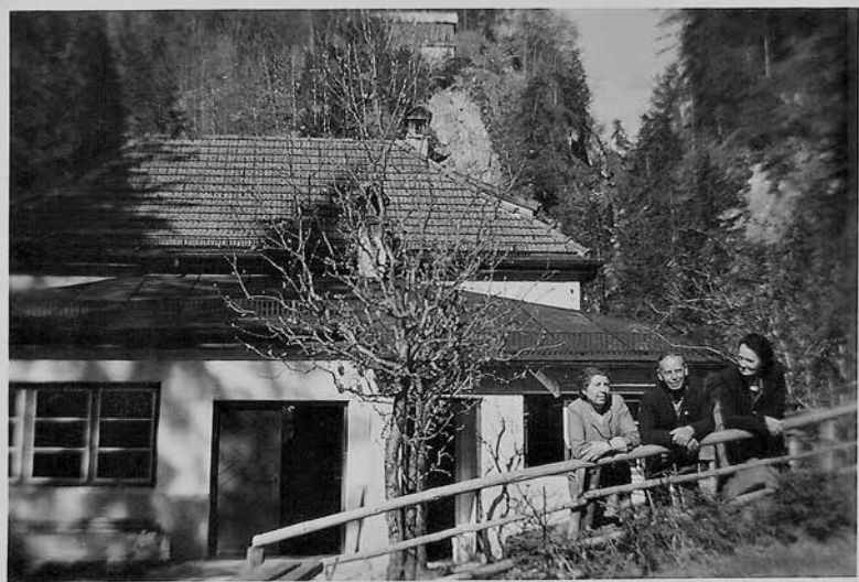
Das Elektrizitätswerk am Ausgang der Gießenbachklamm im Mai 1953
