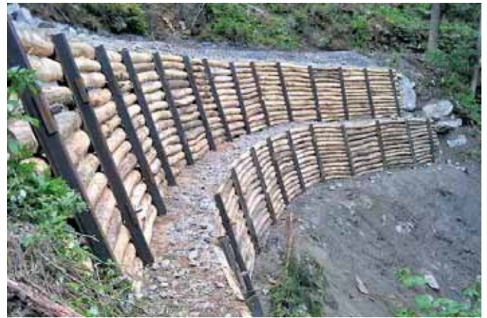
Beispiel einer Holzankerwand
