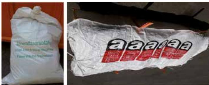
zugelassene Verpackung für Mineralfaserabfälle (links) sowie Asbestabfälle (rechts)
