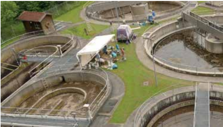
In der weitläufigen Kläranlage werden seit Jahren Produkte der Firma VTA erfolgreich eingesetzt. ©Franz Hoffmann
