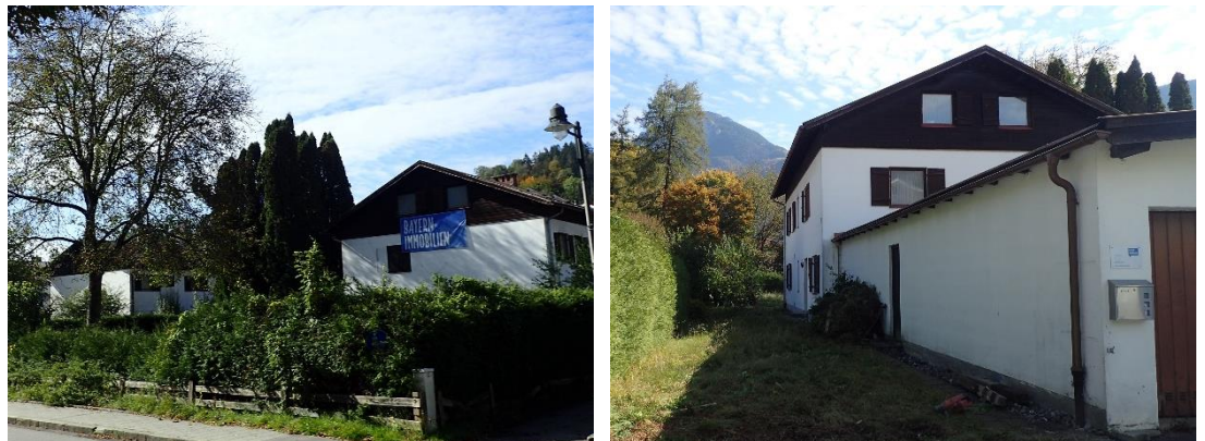
Abb. 2 Bestandsgebäude Pfarrer-Gierl-Weg 16 von Kufsteiner Straße (links) und Lindenweg, Bestandsaufnahme vom 10.10.2022
